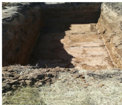
Рис. 9: Котлован (745/245/190). Почва стенок и днище-суглинка
