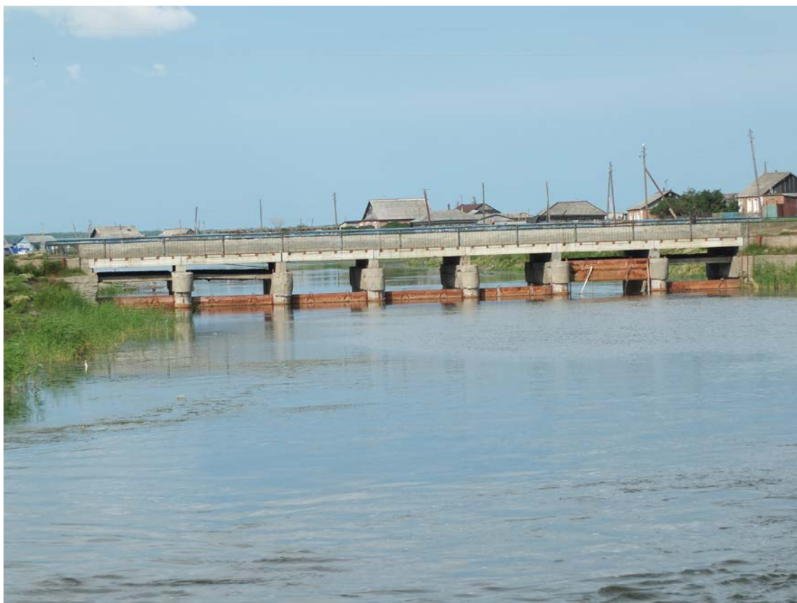
Рис. 1. Плотина-мост в пос. Усть-Логатка на реке Оша, створы которой для снижения обводненности центральной части лесостепной части и восстановления нормального уровня воды для жизни сельских жителей Омской области были открыты лишь в декабре 2018 года (фото С. А. Соловьева, июль 2017 года)
